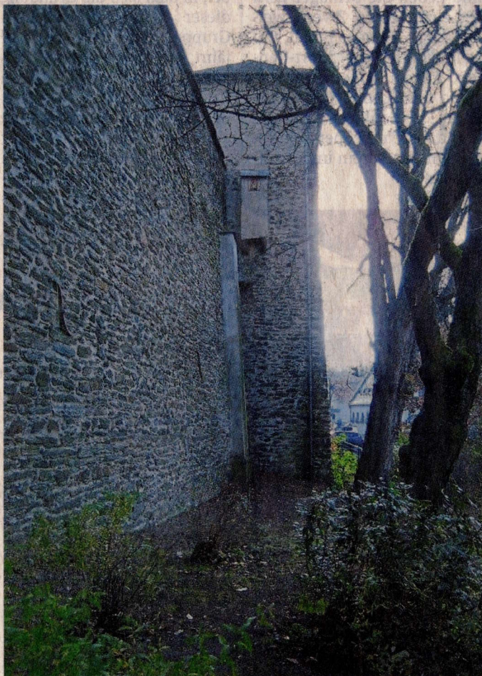
Hier hat sich die Regentin verewigt: Die 15 Meter hohe Schlossmauer wurde 1731 neu aufgebaut. Foto: Christel Lentz
