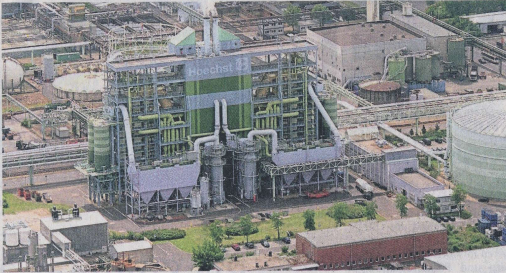
Das ehemalige Hoechst-Gelände in Frankfurt am Main.
